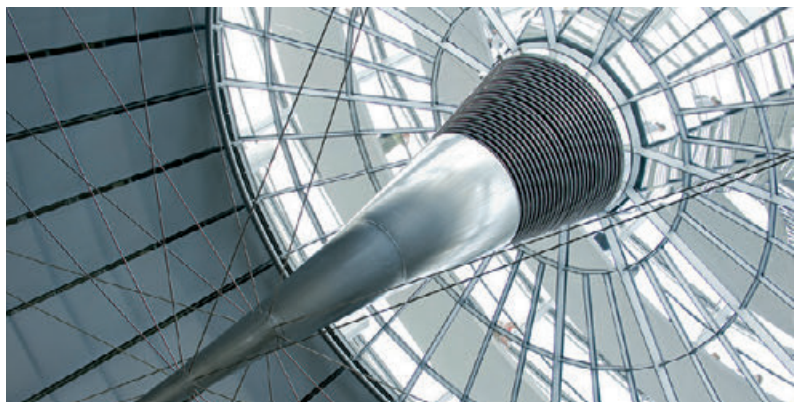
Luz y aire: el embudo de la cúpula del edificio del Reichstag proyecta luz natural hacia el salón de plenos y evacua el aire viciado hacia el exterior.
